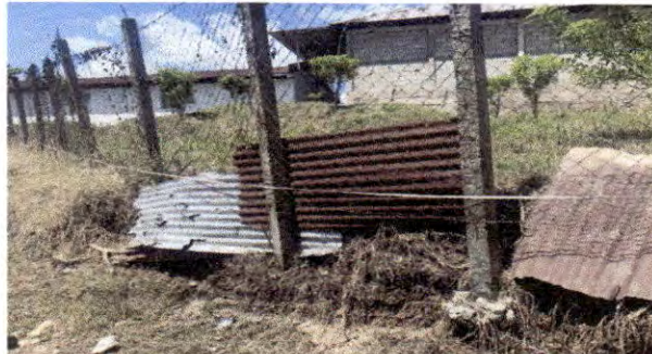
Foto 6: malla perimetral en mal estado y con postes de madera.
